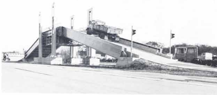
Bild 1: Gesamtansicht der Lkw-Versuchsrampe
